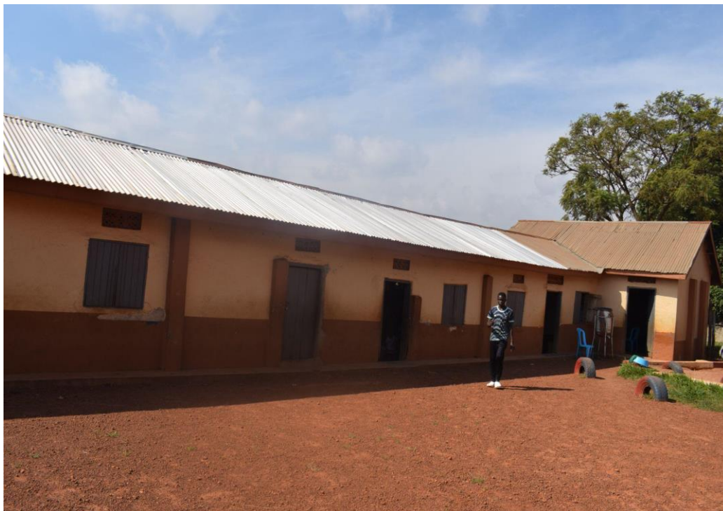
Blocco di 5 aule prima dell'intervento
