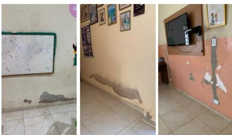
Attualmente **la struttura ha bisogno di alcuni interventi di ristrutturazione**, a causa della forte umidità le aule dell'asilo sono in pessime condizioni: con la muffa e il deperimento delle pareti questo centro non è più un luogo sicuro per i bambini. Dopo un primo intervento di sistemazione delle pareti esterne realizzato nel 2024, ci impegniamo per **ristrutturare le stanze e le aule, per un importo complessivo di € 2.600.**
